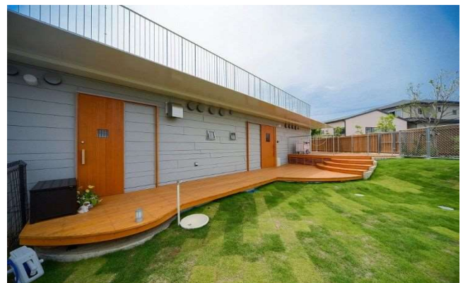
8. こども園・小規模保育施設整備への補助 (既存の小規模保育施設)
