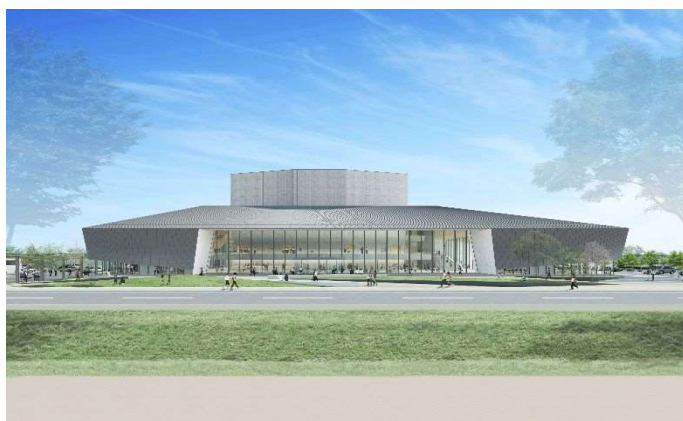
1.（仮称）磐田市文化会館の建設工事の推進 （完成イメージ（正面））
