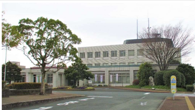
1. 豊田支所等の改修による防災拠点施設の整備 (現在の豊田支所)
