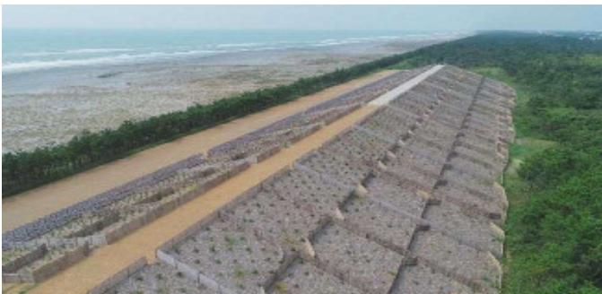
2. 海岸堤防の整備推進（福田地区の整備状況）
