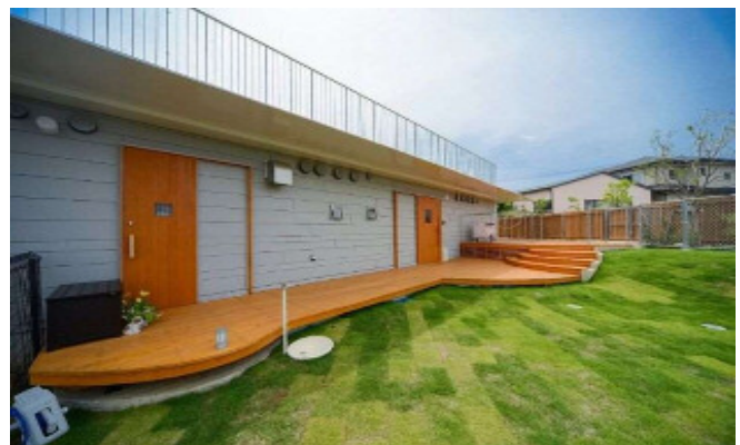
8. こども園・小規模保育施設整備への補助 (既存の小規模保育施設)
