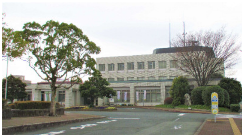
1. 豊田支所等の改修による防災拠点施設の整備 (現在の豊田支所)
