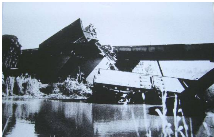
地震のため脱線転覆した貨車(『写真でみる東南海地震』より)
