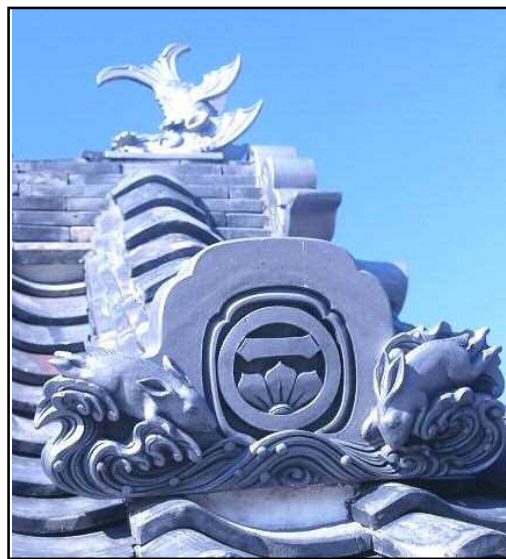
◆脇本陣大三河屋門(屋根瓦の降瓦)
