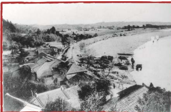
かつてあった神田公園から撮影した 神田港の周辺(大正2年頃)
