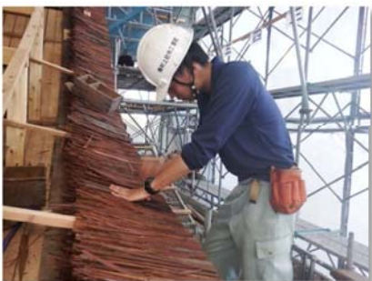
のきつけ 軒付 1尺2寸(約36cm)の軒付皮を、釘で留めながら葺きます
