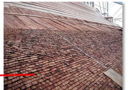
ひらびき 平葺 平らな面にきれいに葺いていくのが、難しいのだそうです
