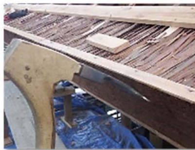
上下の板を物差しにしてチョンナで仕上げます
