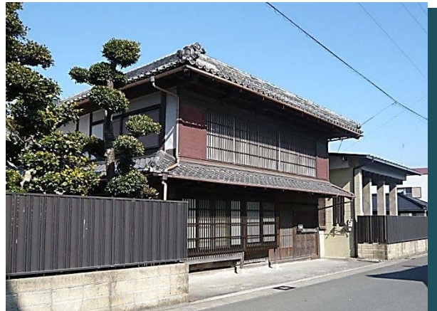
津倉家外観（主屋）～南西から～
