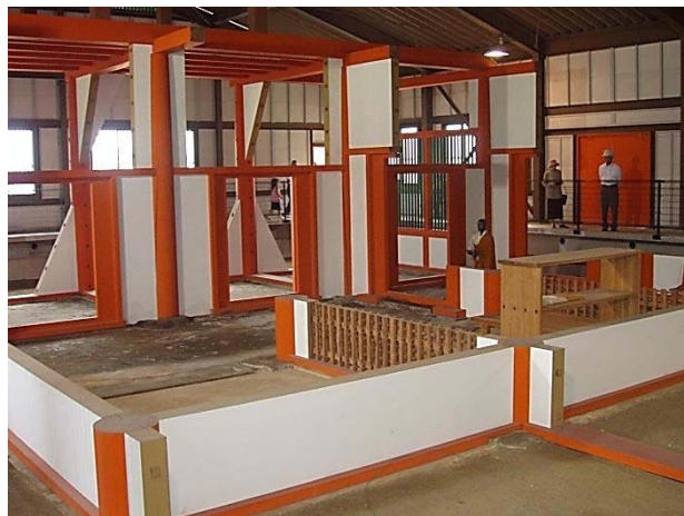
僧房跡の内部の復元(讃岐国分寺跡)
