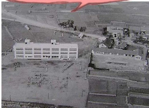
↑ 建設当時(昭和29年)の豊田南小学校
