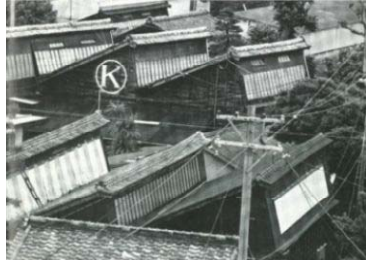
のこぎり屋根（織物関係の産地によくみられた工場の屋根） （1981 福田町勢ガイドより）
