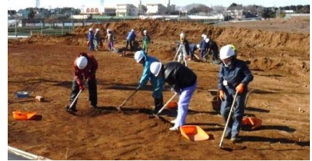
地面を掘り下げている様子
