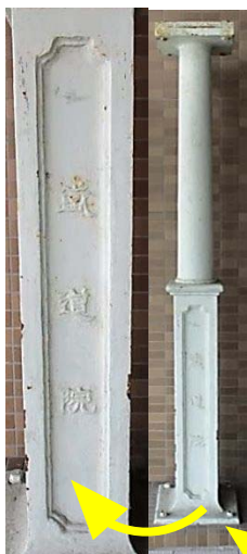
跨線橋支柱の一部
