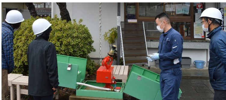
放水銃の使用方法確認
