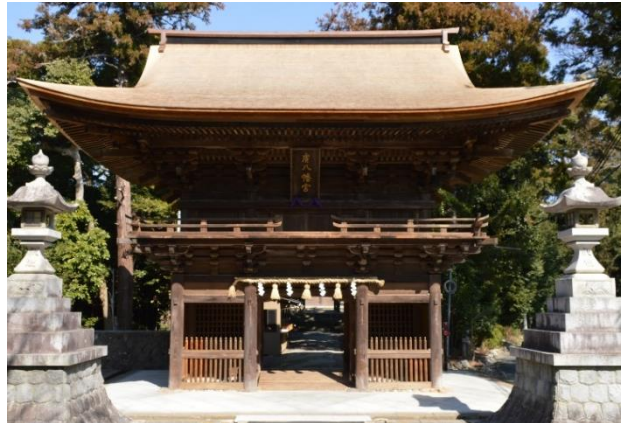
県指定（建造物）の府八幡宮楼門
