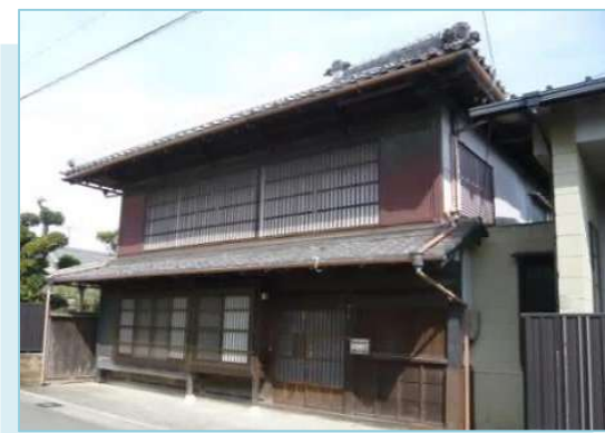
明治22年に建てられた主屋
