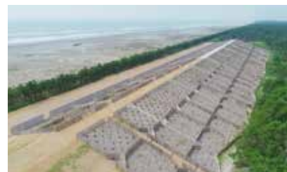
海岸堤防の整備
