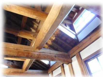
図書蔵 2 階吹抜け部
