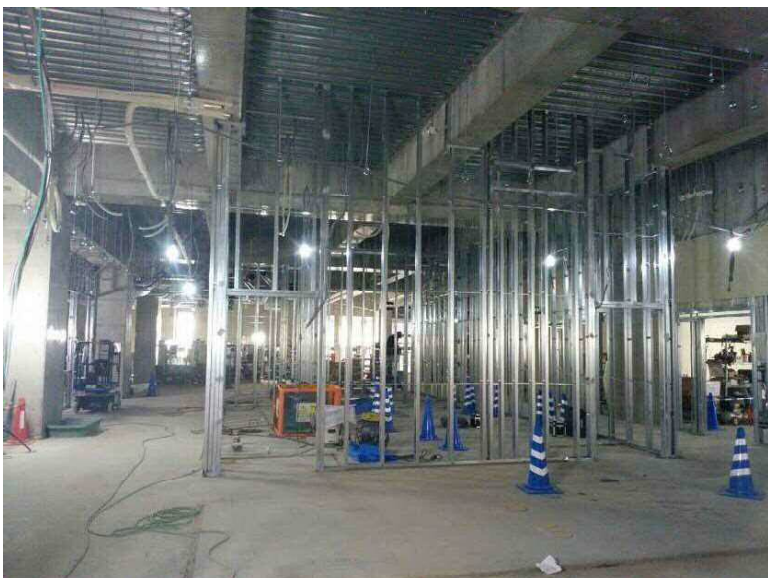
校舎棟1階 03WC(男・女)1
