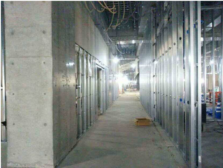
校舎棟1階 05北廊下1(1)
