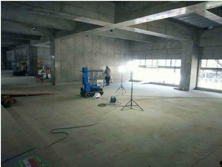
アリーナ棟1階 03武道場
