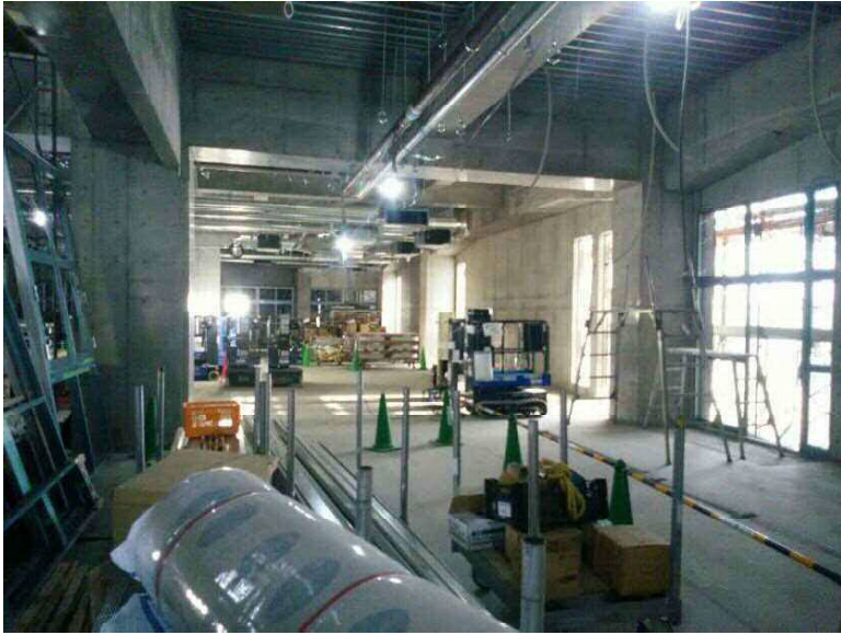
校舎棟1階 01ランチルーム前
