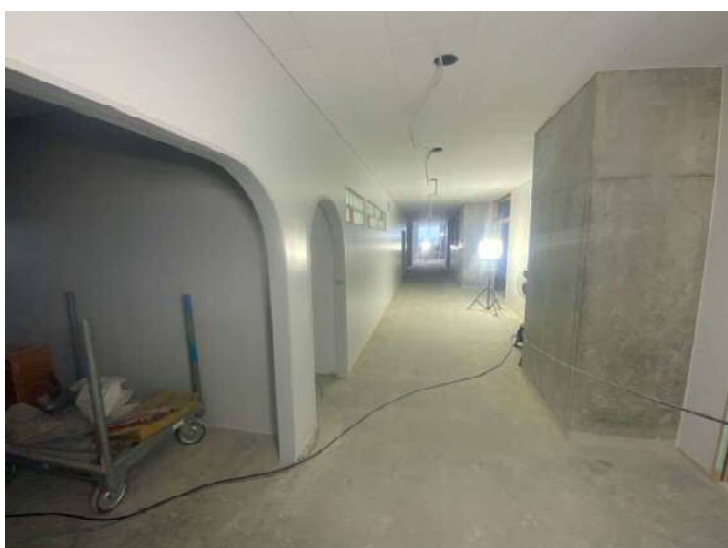
校舍棟3階北廊下
