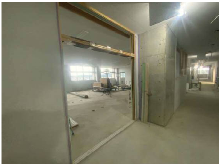
校舎棟4階美術室
