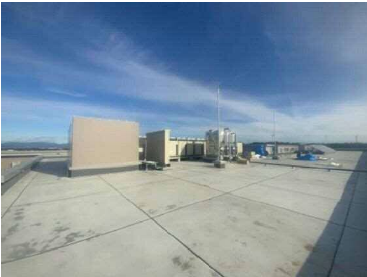
校舎棟R階
