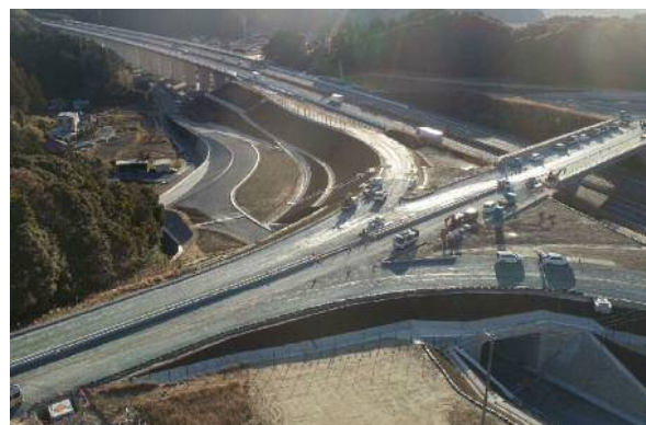
2. 新磐田スマートインターチェンジの完成・供用開始 (R3.1月現在の様子)
