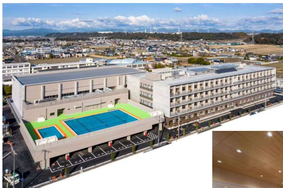
1.ながふじ学府小中一体校グラウンド等の整備 (写真は完成した校舎・ながふじホール)
