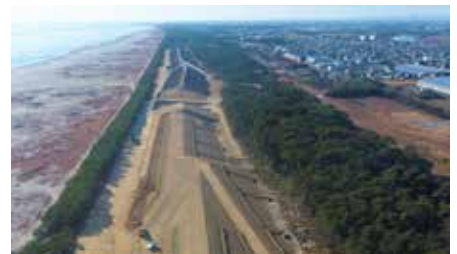
① 海岸防災林工区
