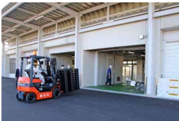
▲搬入出を効率的に行うため、入口や床が改修されています
