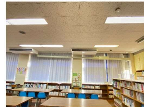
特別教室空調設備設置
