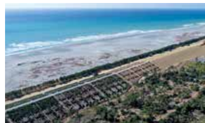
海岸堤防 (令和4年3月撮影)
