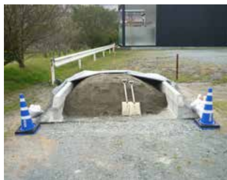
▲本庁舎北側に設置された土のうステーション
