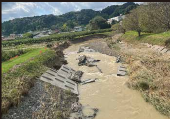
激しい濁流で護岸ブロックが流され、堤防は決壊した。(敷地川)
