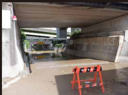
国道1号線との立体交差の下を通る市道は、冠水し通行止めとなった。(三ヶ野)
