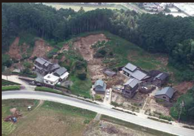
何カ所もの土砂崩れが発生し、山肌があらわになった。(下野部)
