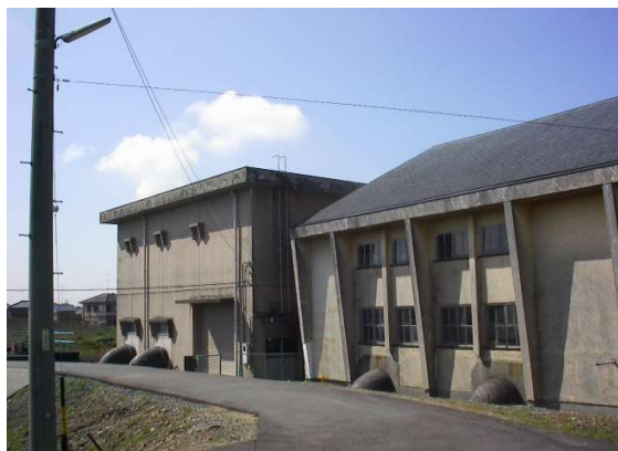
(左)大池排水機場：(右)二之宮排水機場
