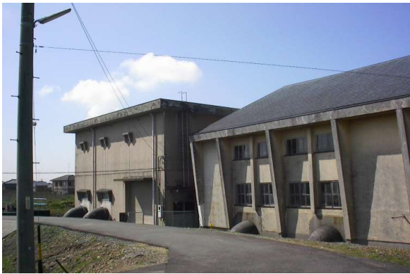
(左)大池排水機場：(右)二之宮排水機場
