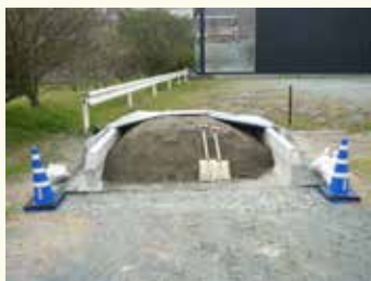
▲西庁舎北側に設置された土のうステーション
