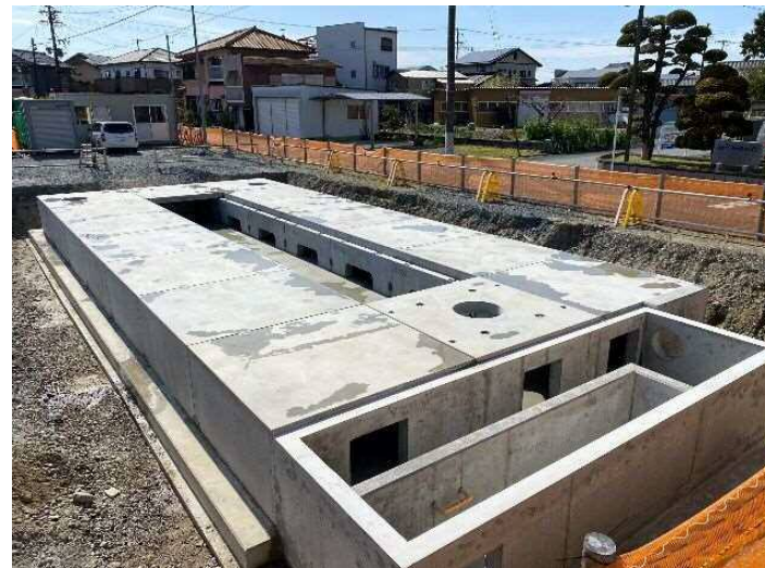
〈地下調整池〉 埋戻し前の状況です 敷地内の雨水を流末排水路に 調整排水します（東側から望む）
