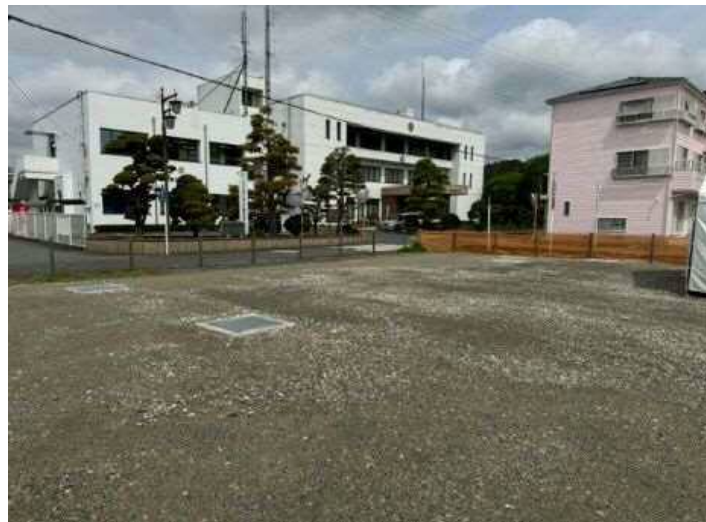
〈新築場所から見た現支所〉 南側から北側を見ている 車庫や書庫を解体した箇所に 調整池を設置しました
