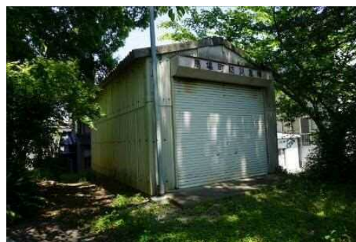
写真 68 馬場町防災倉庫
