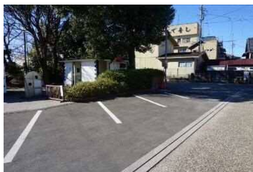
写真 88 駐車場の現況
