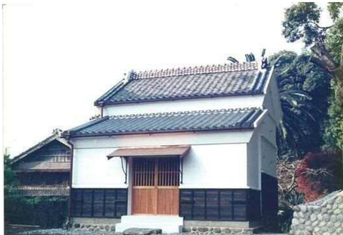
写真 47 磐田文庫 (平成4年 12月修理竣工時)
