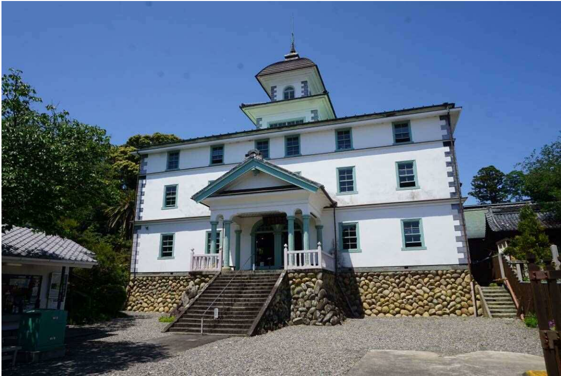
旧見付学校現況 令和3年5月
