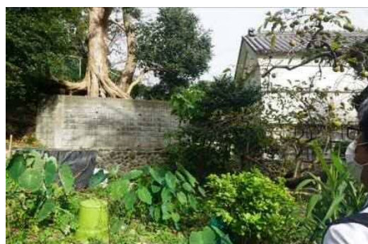
写真 87 北側擁壁の現況(西から)
