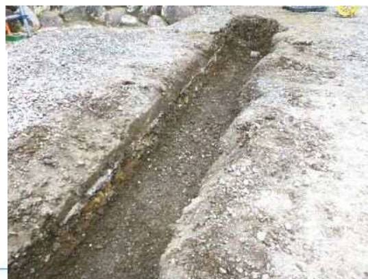
写真44 平成28年度消火設備改修工事 既存配管敷設状況
