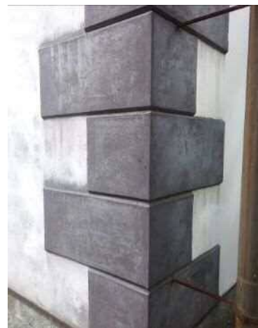
写真29 四隅の黒漆喰
