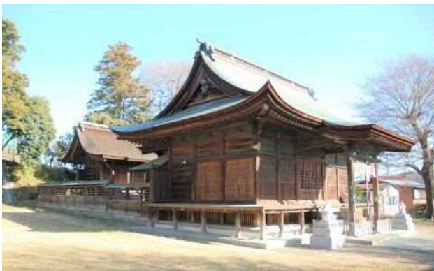
写真52 淡海国玉神社社殿全景
