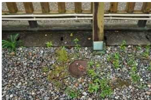
写真 40 汚水管 敷地南
