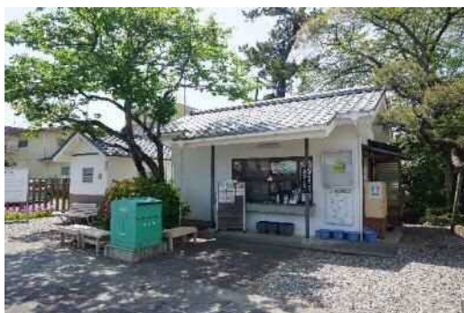
写真 36 管理棟(右)・ポンプ小屋(左奥)放水銃(左手前)
