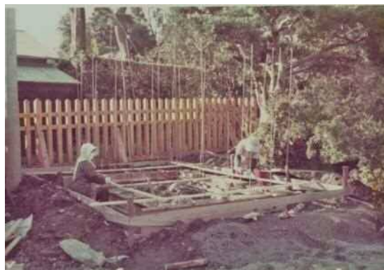
写真43 昭和54年度 ポンプ小屋設置工事状況
