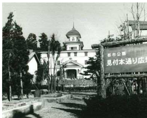
写真 89 竣工当時の本通り広場 (昭和56年[1981])
