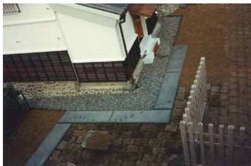
写真 86 環境整備工事竣工状況
