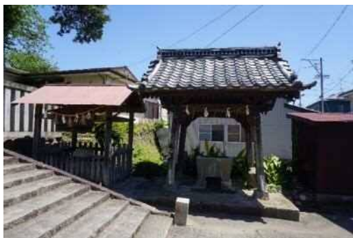
写真 61 井戸小屋及び手水舎
