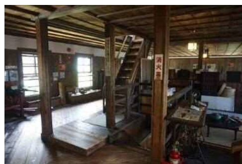
写真 34 3階に残された塔屋の柱
