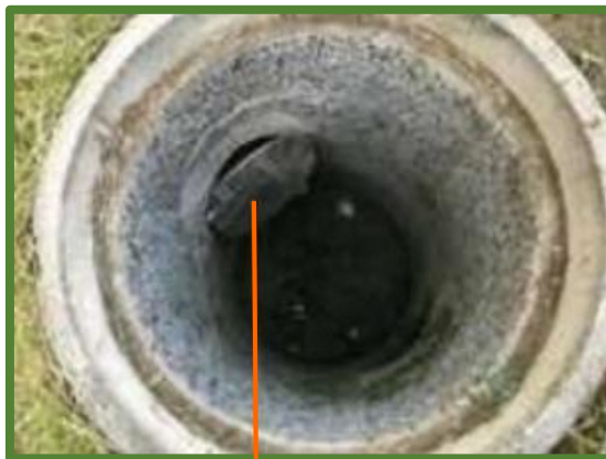
① 排水管接合部の金網
